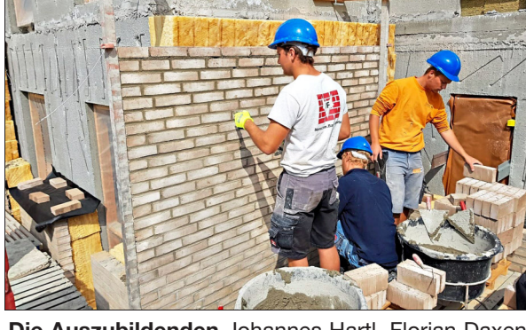
Die Auszubildenden Johannes Hartl, Florian Daxenberger und David Hillebrand auf der Baustelle einer großen Wohnanlage in Dänemark.
